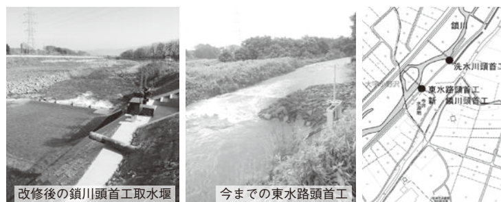
改修後の鎖川頭首工取水堰
