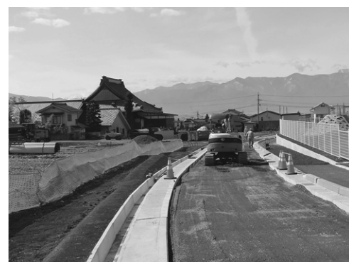
公民館敷地隣接の市道2736号線の改良工事 （3月末終了予定）
