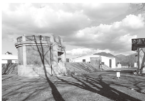
手前が接合井 真ん中に入口棟 南西より
