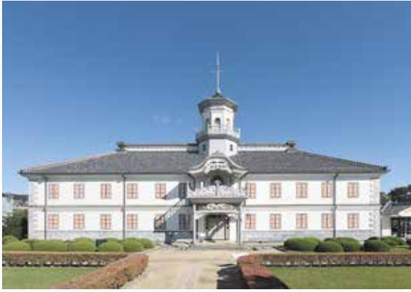
旧開智学校 国宝 (明治、開智) 現在は女鳥羽川沿いから移築され、教育博物館として保存活用している。
