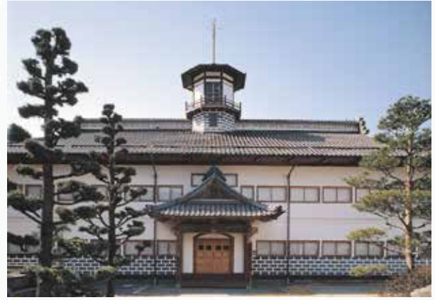
旧山辺学校 県宝 (明治、里山辺) 開智学校の「ギヤマン学校」に対し「障子学校」と呼ばれた。
