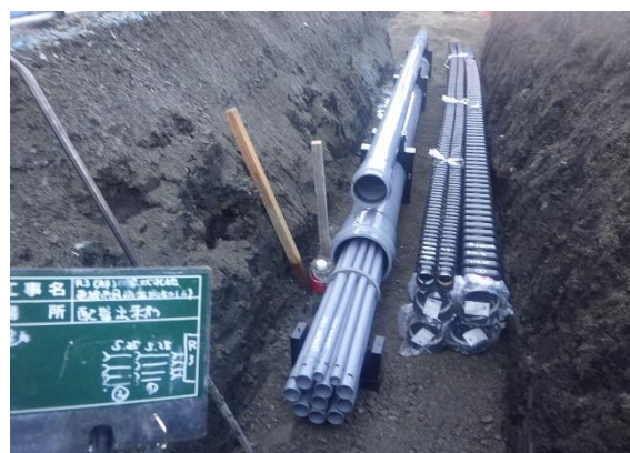
無電柱化(電線共同溝整備)施工状況 (都)内環状北線(大手)
