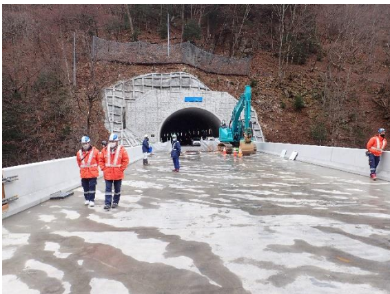
国道 158 号奈川渡改良
