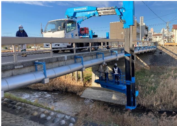
橋りょうの点検
