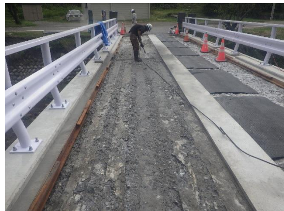
橋りょうの修繕(寺前橋(四賀・保福寺))
