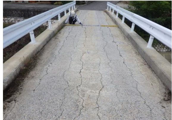
今後修繕予定の橋りょう(四賀・赤怒田)
