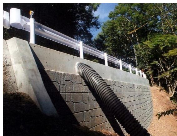
法面崩壊対策工整備 (市道角ヶ平大白川線(奈川))
