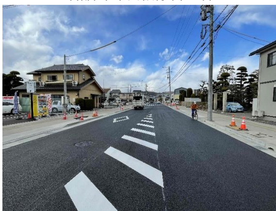
無電柱化(電線共同溝整備)施工状況 (都)中条白板線(巾上)
