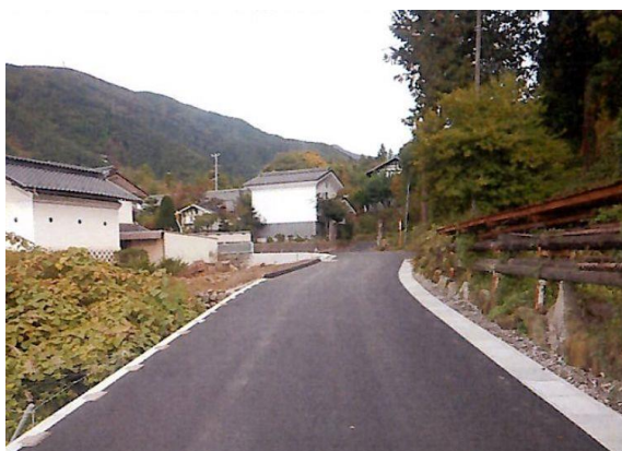
生活道路の整備 (市道 3651 号線(入山辺))
