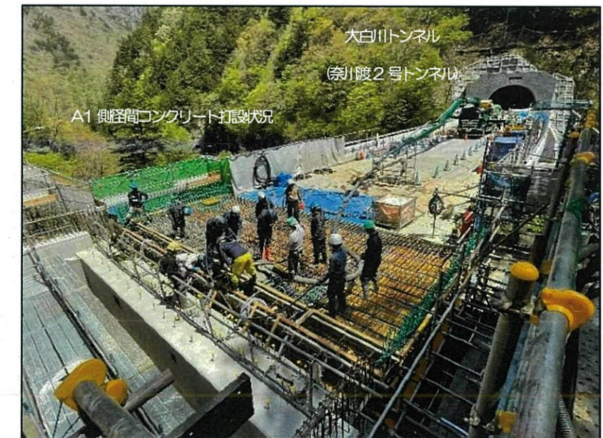
~A1 側径間施工状況
