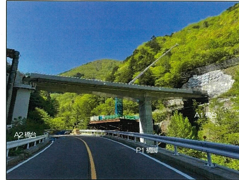
~大白川大橋全景~
