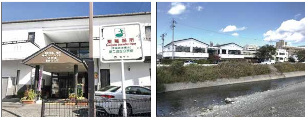
▲第二地区公民館（左：避難場所の掲示状況、右：隣接する薄川）
