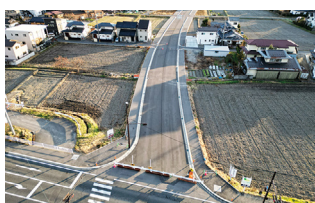
工事中の島立地籍の市道 7003 号線
