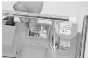
(7) 融着は、継手端子に出力ケーブルを確実に接続した後、融着データを取込みコントローラのスタートボタンを押し通電を開始すること。
