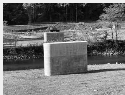
▲建設中の橋脚
