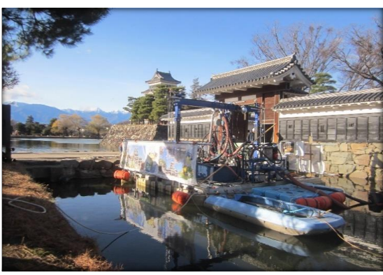
令和5年度の浚渫作業の様子
