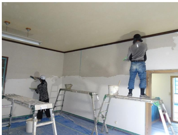
旧開智学校校舎 耐震対策工事の様子①
