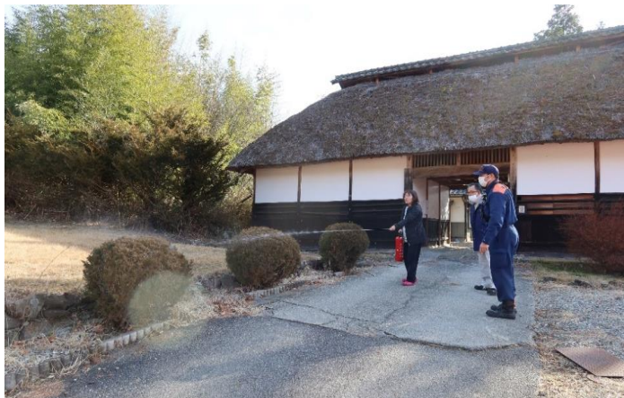
松本市重要文化財 松澤家長屋門
