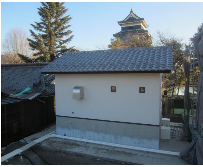
新規送水設備(ポンプ室)設置状況
