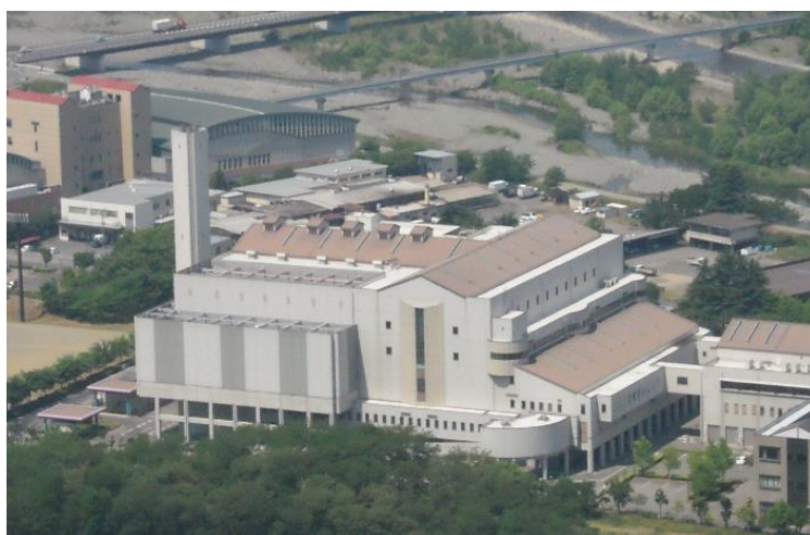
松本クリーンセンター
