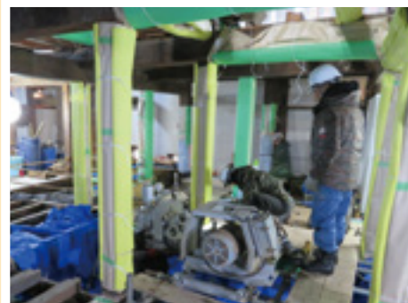
天守1階の調査の様子
