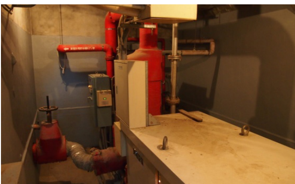
写真 4-5 屋内消火栓（左上）
