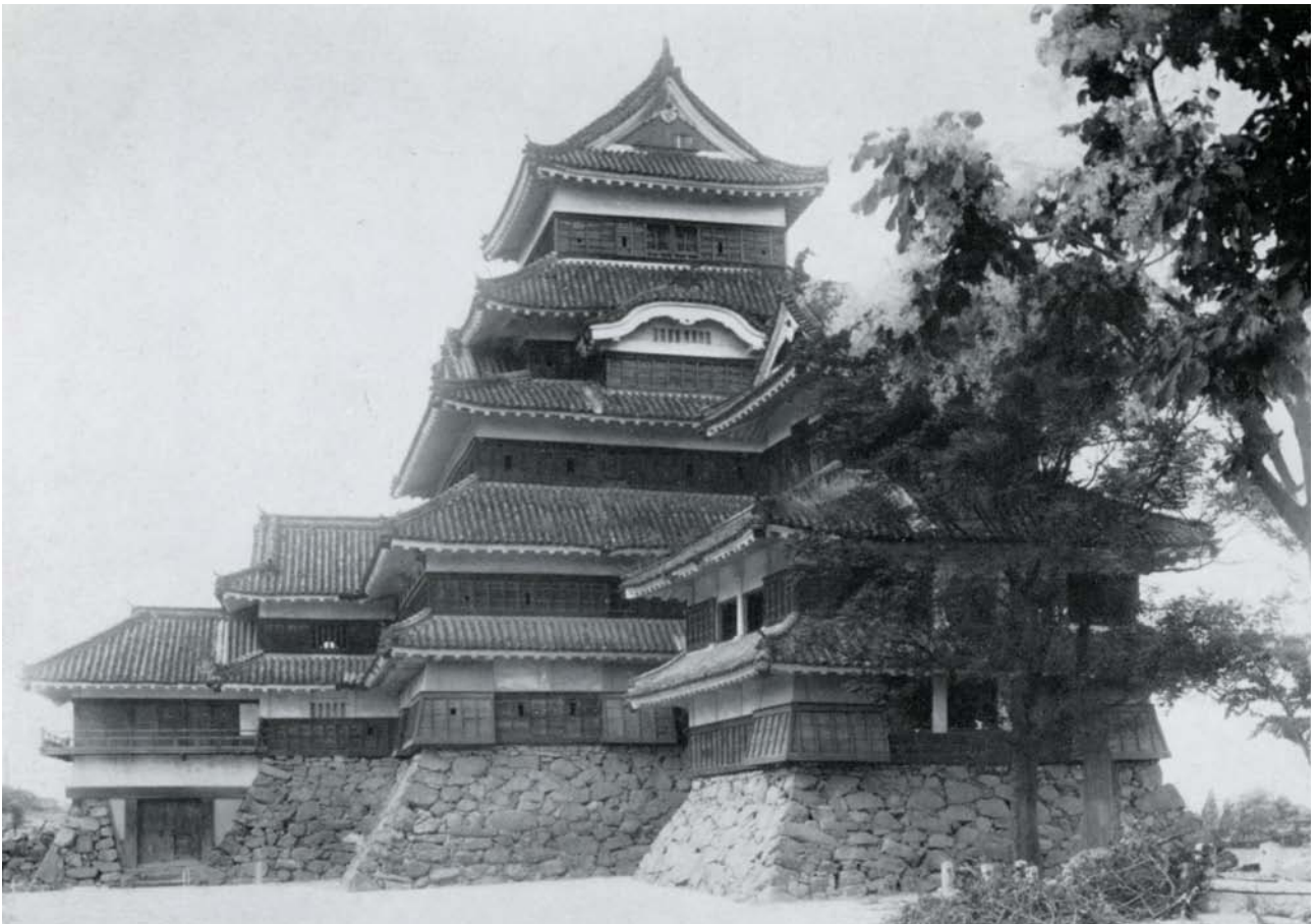
写真 1-5 天守北面（昭和の大修理前）
