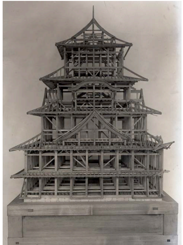
写真 1-15 松本城天守木組模型（南北面）
