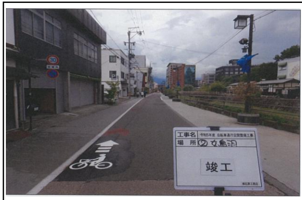
【女鳥羽川の矢羽根マーク 施工後】
