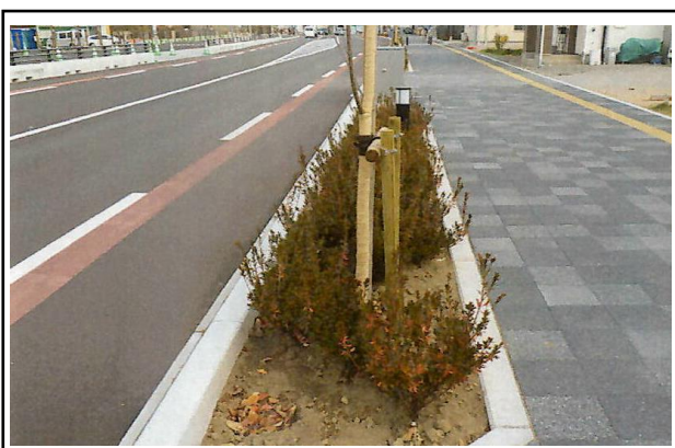
【内環状北線の自転車専用通行帯 施工後】
