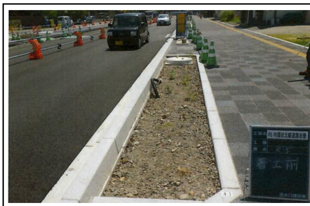
【内環状北線の自転車専用通行帯 施工前】
