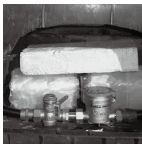
保温の例（メーターボックスの断面）
