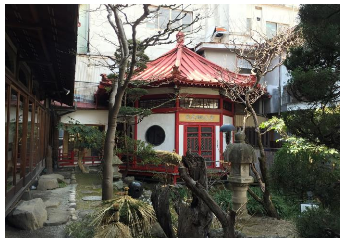
28-42-2 割烹 松本館 便所棟
