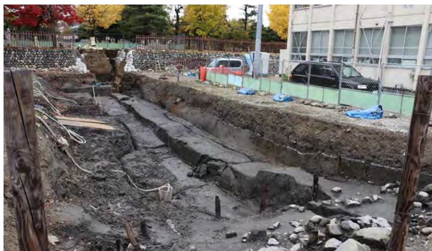
写真6 南外堀 横断調査の様子（令和4年度）
