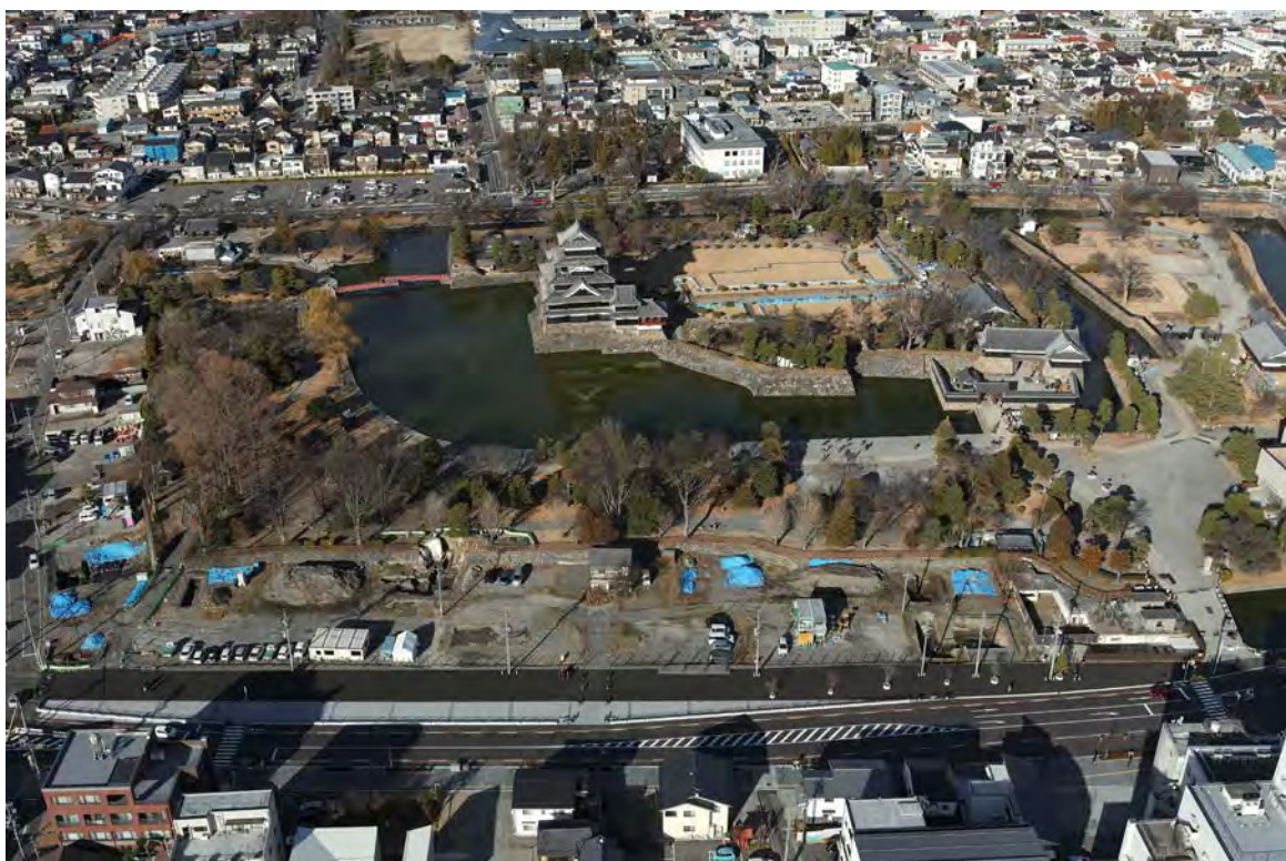
写真1 松本城 上空南から撮影（撮影日：令和5年12月18日）
