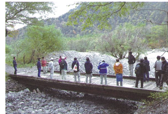
－ 土砂で埋まった徳沢の橋付近 －
