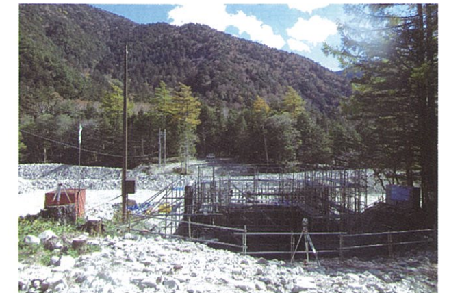
－ 新村橋工事現場 －
