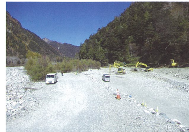
－ 横尾下流付近の連絡道工事現場 －
