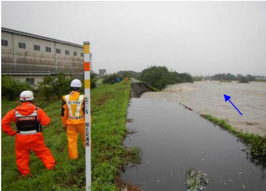
被災箇所 応急復旧着手前 (R3.8.15撮影)
