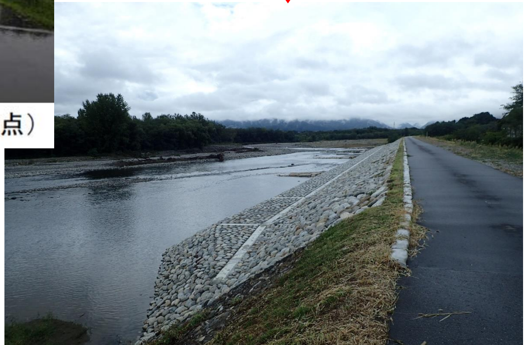
災害復旧工事完了後(R5年9月撮影)
