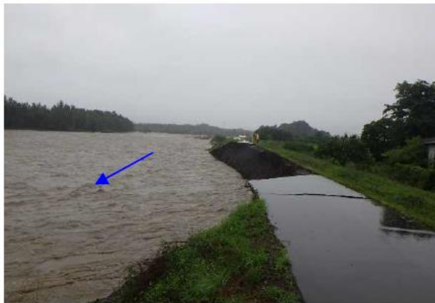
応急復旧作業前(8月15日時点)
