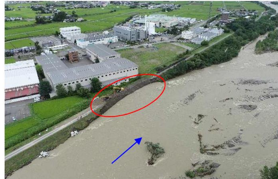
被災箇所 応急復旧工事中 (R3.8.16撮影)
