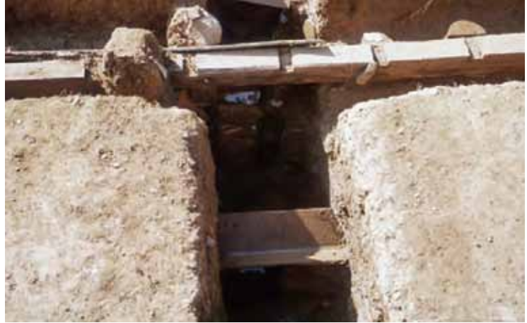
半地下工場屋根基部材(上)と床付近の部材(下)
