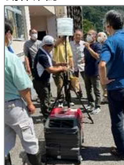
発電機・投光器の動作確認
