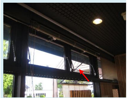
排煙窓の開閉作動の確認 をしましょう
