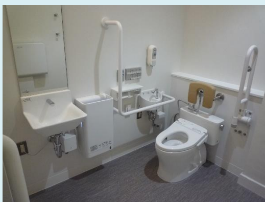
多目的トイレ
