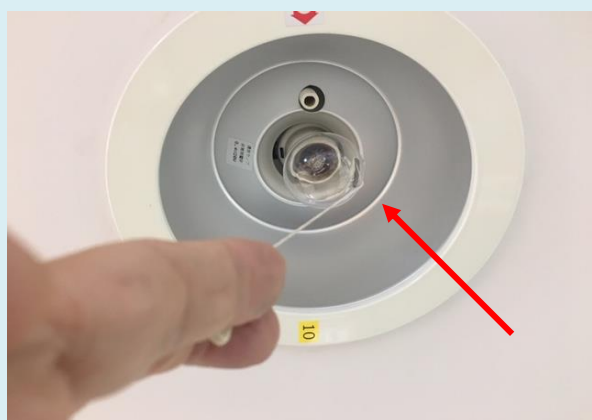
非常用照明の点検
