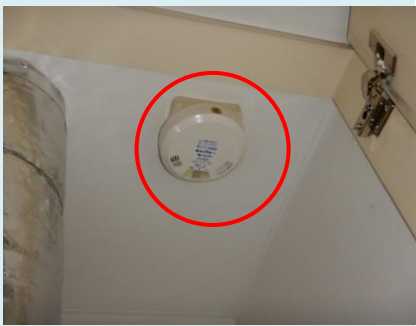
ガス漏れ警報器
