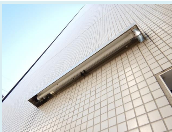
屋外照明 錆や汚れの状況を確認
