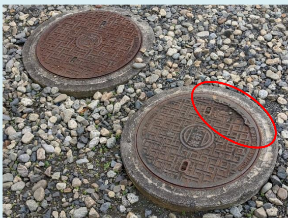
マンホールが損傷しています
