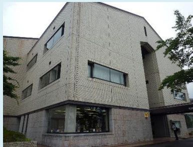
外壁（石・タイル）
