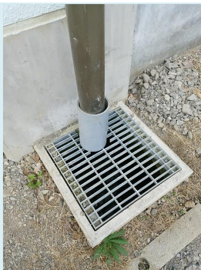
雨水柵・竖樋
