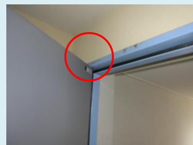
防火区画の常時閉鎖扉のドアク ローザーが無くなっています
