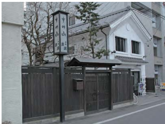
隣接する蔵づくりの建物や、伝統的な板塀に呼応したサイン
