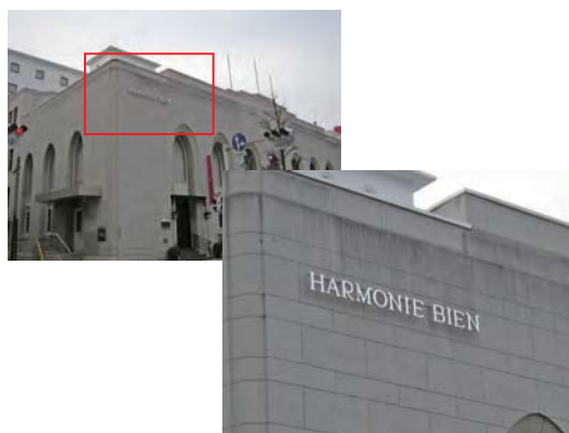
切文字を壁面から離して設置し、素材に金属を使用して、比較的小さな文字をクリアに見せている
