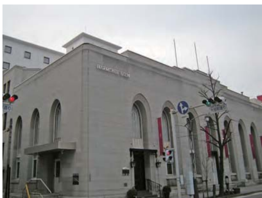
切文字を壁面から離して設置し、素材に金属を使用して、比較的小さな文字をクリアに見せている
