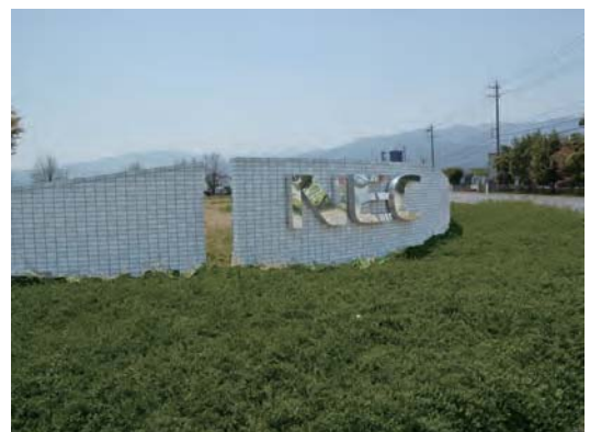
丸みを付けた低い盤面と修景緑化により圧迫感を減じた大型サイン
