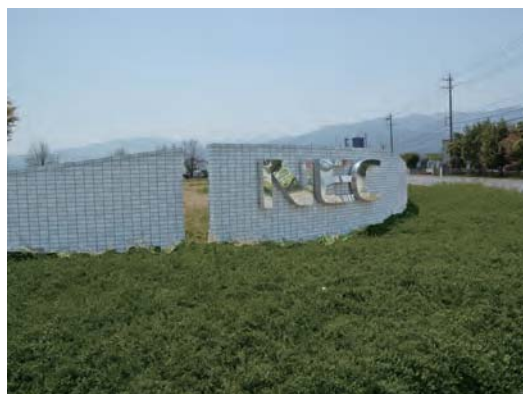
丸みを付けた低い盤面と修景緑化により圧迫感を減じた大型サイン
