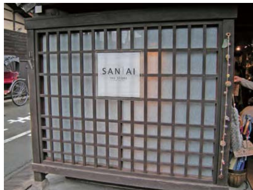
格子状のサイン盤面から障子風の建具が透けて見え、違和感のない仕上がり【岐阜県高山市】
