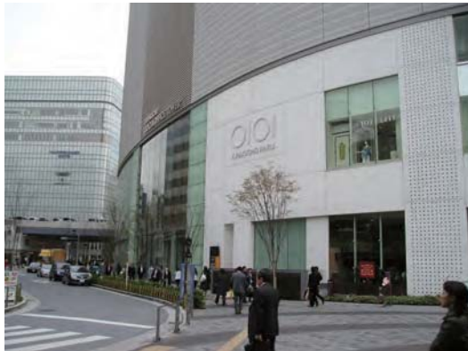
低彩度の壁面と同色彩の切文字による店舗マーク 【東京都千代田区】
