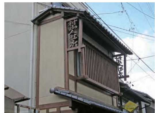
通りのイメージに合わせたファサード（看板建築）に一体化された透かし彫りサイン
