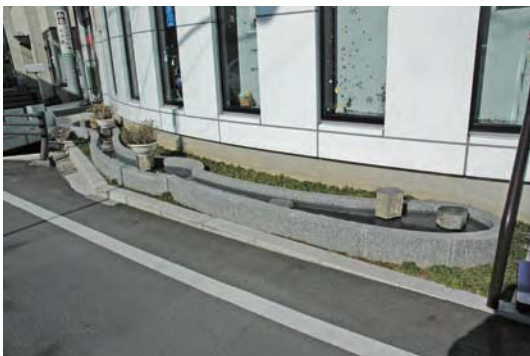
道を挟んで向かいにある「源智の井戸」に呼応する水の仕掛け
