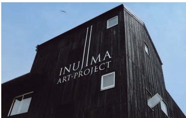
伝統的な意匠と地域素材である 焼板杉の壁面に印されたステン レスの切文字によるサイン
