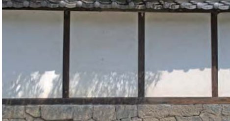
伝統的な瓦、漆喰、木、石の組合せ
