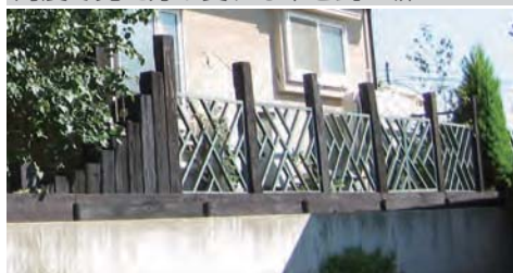
現代的金属材料と伝統素材の木材の組合せ
