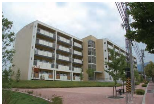
ルーバー+壁で覆った階段部と建物の一体化
