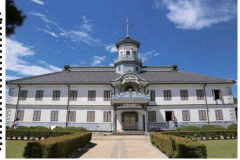
旧開智学校校舎の背景に近代的な建物等が視界に入らず保全されていることで、往時の雰囲気をしのぶことができる良好な景観
