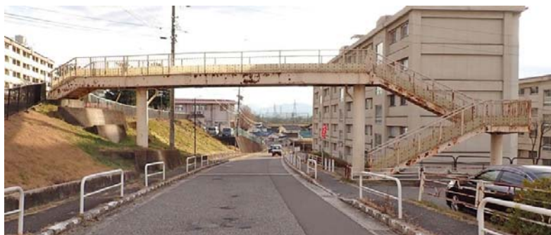
写真 5.1 並柳横断歩道橋
