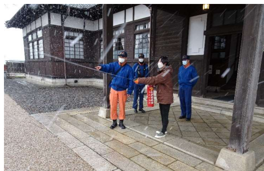
重要文化財 旧松本区裁判所庁舎
