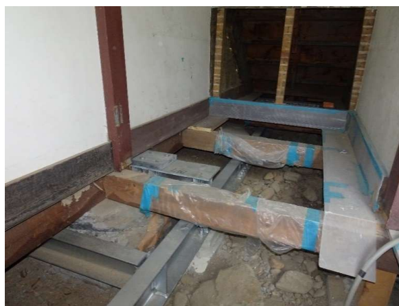
旧開智学校校舎 耐震対策工事の様子②
