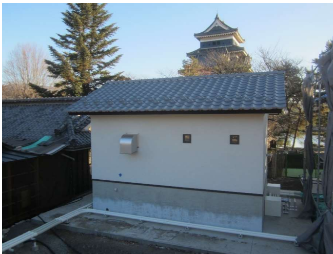
新規送水設備(ポンプ室)設置状況
