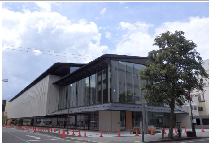
新築工事完了 (東南側大名町通りから)
