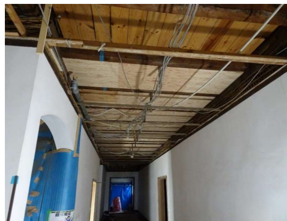
旧開智学校校舎 耐震対策工事の様子③
