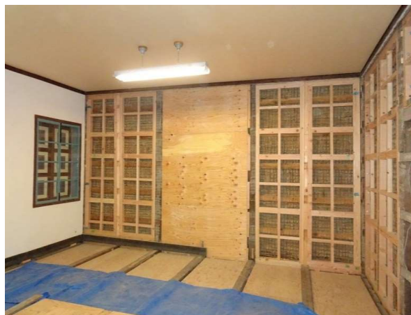
旧開智学校校舎 耐震対策工事の様子①
