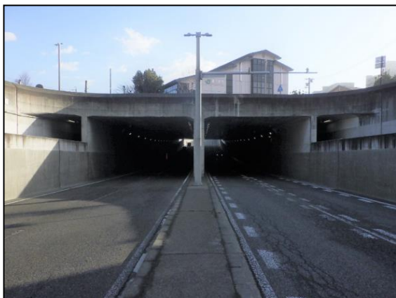
白板大型ボックスカルバート（1999年竣工）
