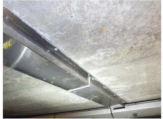
[ブロック 04 : 頂版部 03,04 継手部の SUS 製ドレン設置状況]
