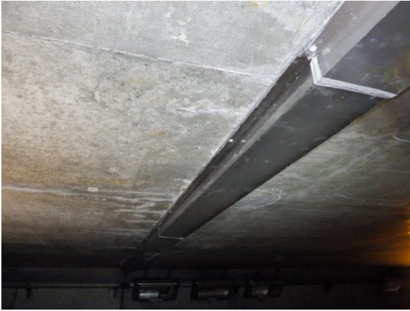
[ブロック 04 : 頂版部 03,04 継手部の SUS 製ドレン設置状況]
