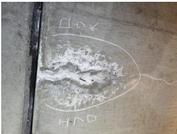
〔頂版：連結部周辺の伝い水、ひび割れからの遊離石灰〕
