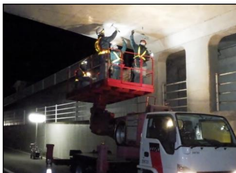
島立大型ボックスカルバート 点検状況（令和3年11月）
