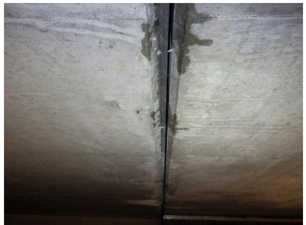
〔頂版：連結部周辺の伝い水、ひび割れからの遊離石灰〕
