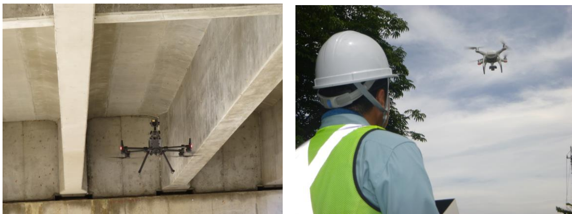
UAV（ドローン）による点検
