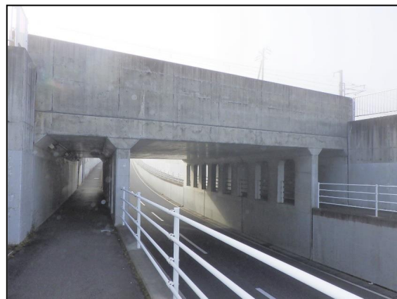
高立大型ボックスカルバート（2002竣工）
