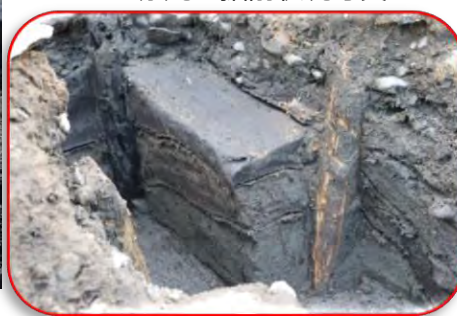
左赤丸 掘削状況写真
