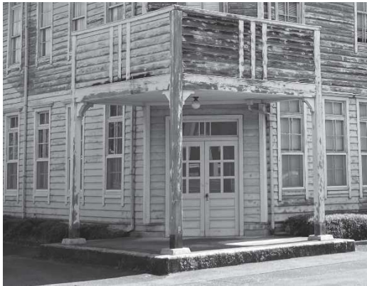
写真（玄関ポーチ）
