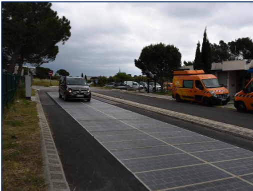
路面埋込型太陽光パネル (フランス・マルセイユ 2017年5月)
