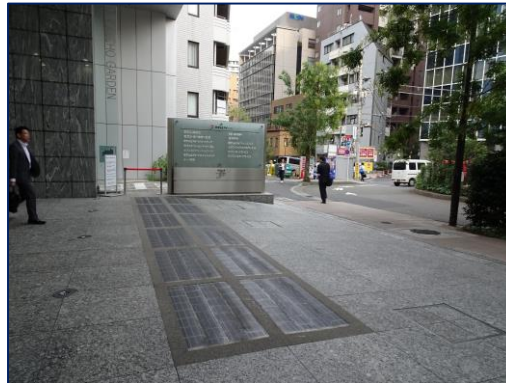
店舗前の路面埋込型太陽光パネル (セブンイレブン千代田二番町店 2019年9月)
