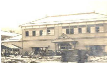
＜建設途中の校舎＞
