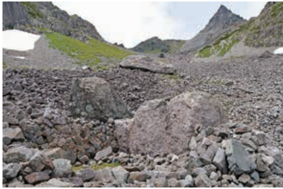
槍ヶ岳の石室 長野県による建設（大正8年）
