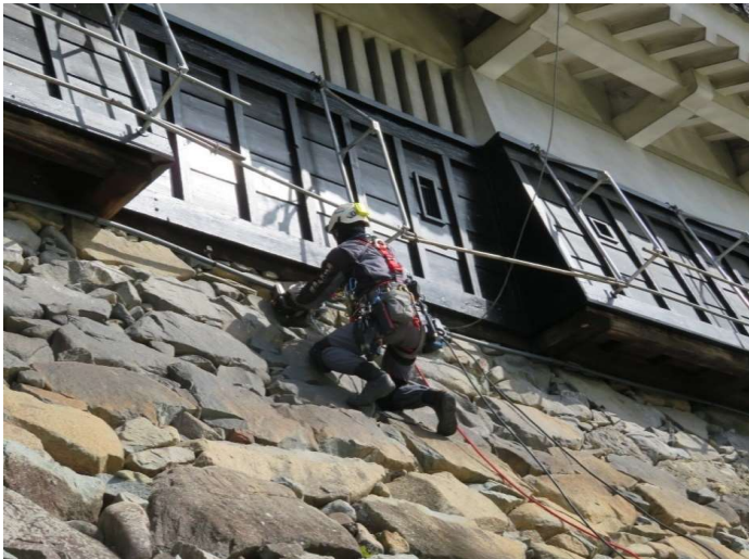
令和2年度に実施した石垣調査の様子
