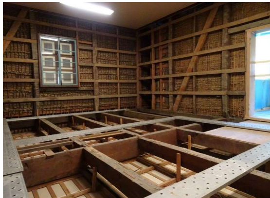
旧開智学校校舎 耐震対策工事の様子
