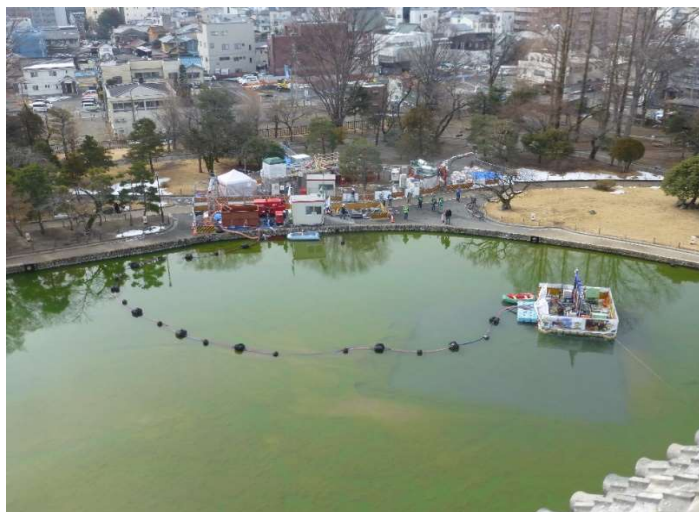
令和2年度に実施した浚渫工法実証実験の様子
