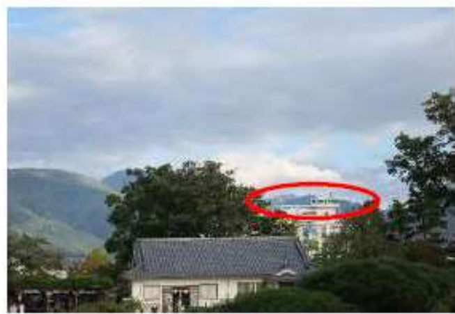
現市役所庁舎 高さ制限を超過している
