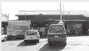
平成1(1989)年8月 北松本駅舎
