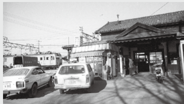
昭和56(1981)年3月 荷物車と北松本駅舎
