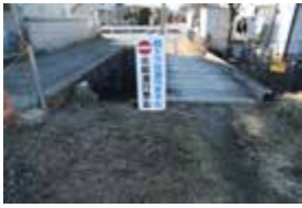
① 通行禁止看板・ 街区表示板
