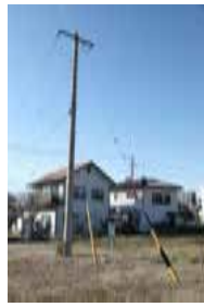
② 電柱と支線
