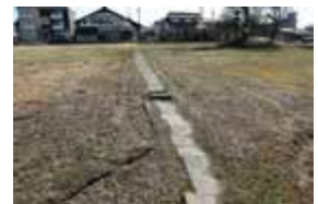
⑳ 畦畔ブロック (里道)
