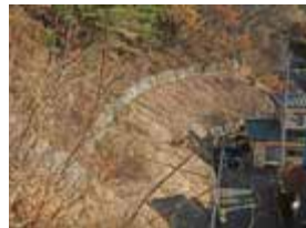
⑭ 治山施設
