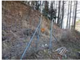
① 鳥獣被害防止防護柵 ゲート
