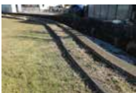
㉕ 畦畔ブロック
