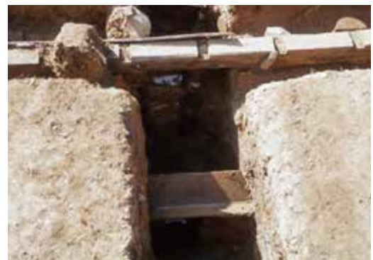
半地下工場屋根基部材(上)と床付近の部材(下) (林山腰遺跡)
