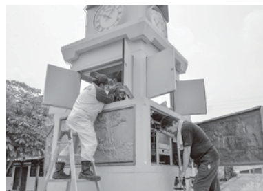
松原モールの時計台を修理しています
