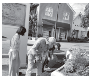
松原モールのベンチの塗装をし直しています
