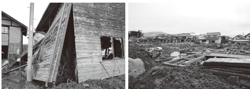
台風19号被害の様子
