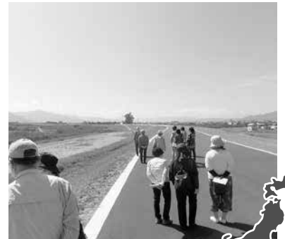
完成された堤防
