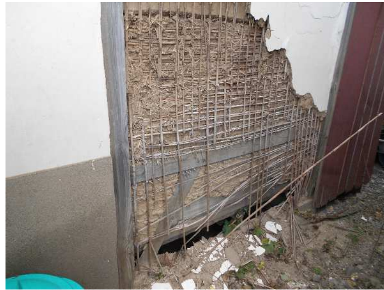
外壁の破損
